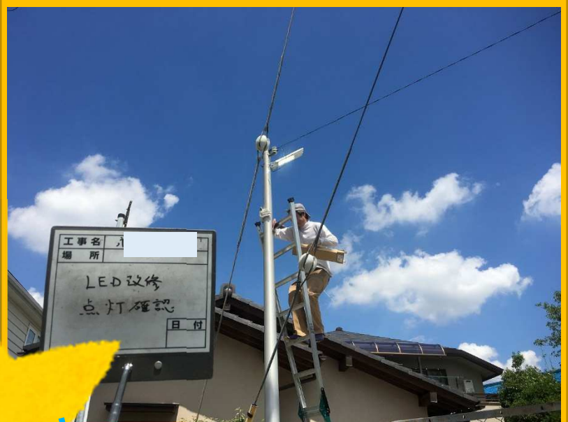
4.取替後、点灯確認
