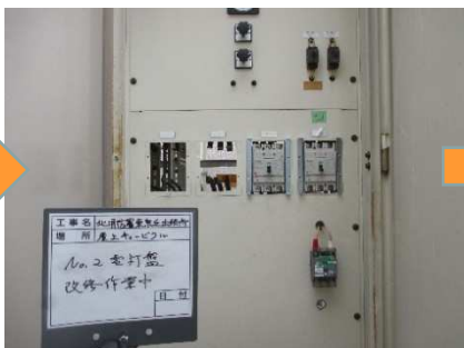
①No. 2 電灯盤交換
